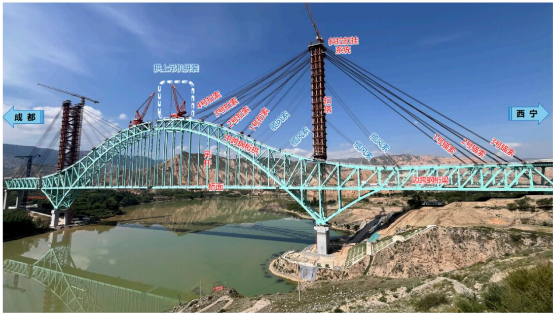
图1 斜拉扣挂系统
