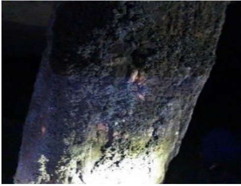
图 3 木点柱上的煤尘结焦
