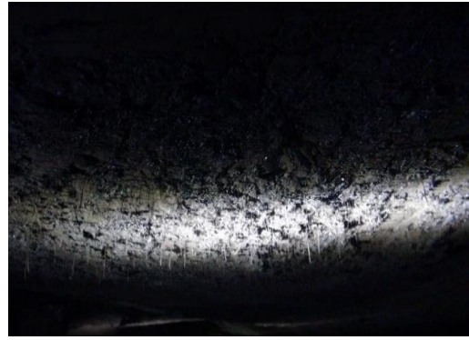
图 4 顶板上的煤尘结焦
