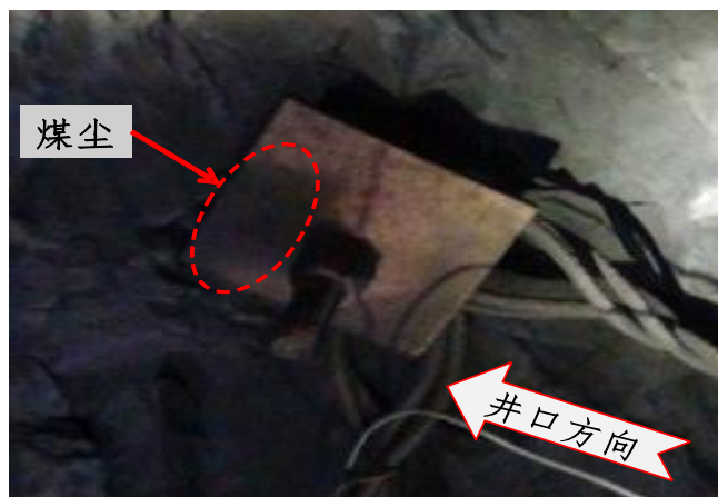
图5 北一运输平巷1#采煤眼至+93米下部车场段的巷道顶板锚杆
