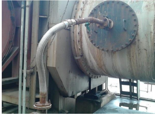
图 2-1 用氮气赶完煤气未脱开氮气管或堵盲板
