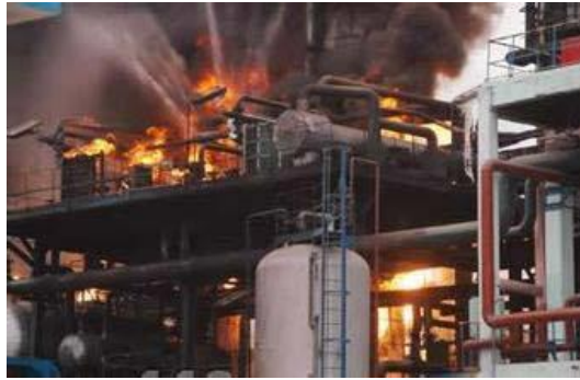
图 2-4 除尘器着火、爆炸
