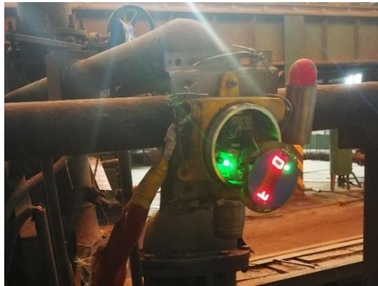
图 2-2 固定式一氧化碳监测报警装置损坏
