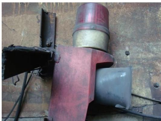
图 2-3 泥炮声光信号故障
