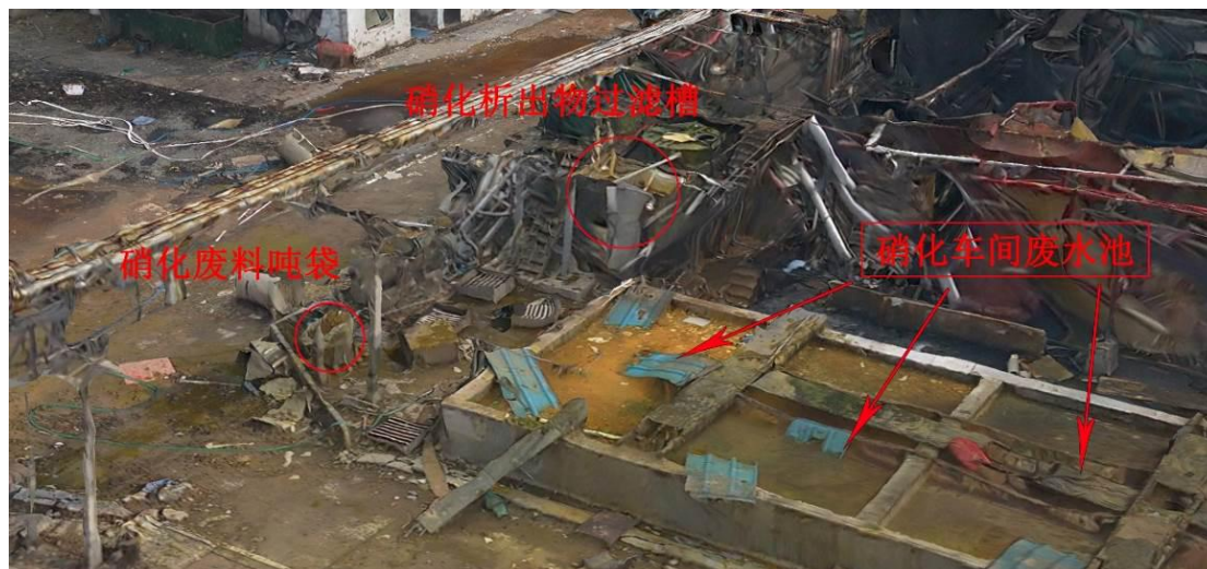
图3 硝化车间废水处理设施
